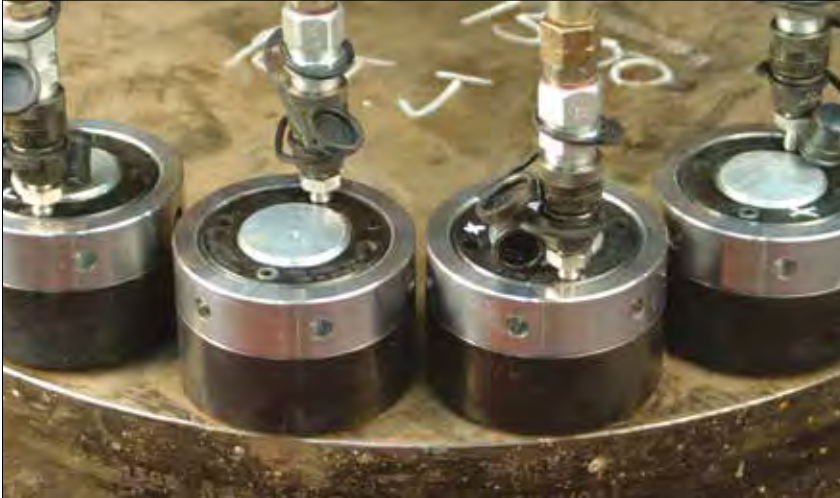
▲ Tensionado con tuercas hidráulicas.
