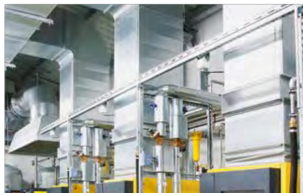
Canal de salida para calentar estancias anexas
