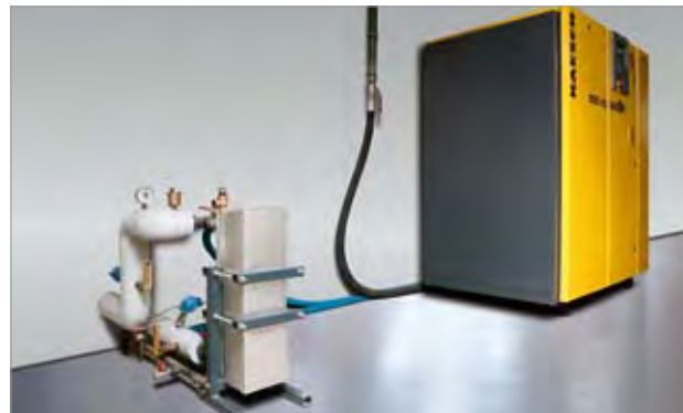
Suministro de calor al sistema de calefacción
