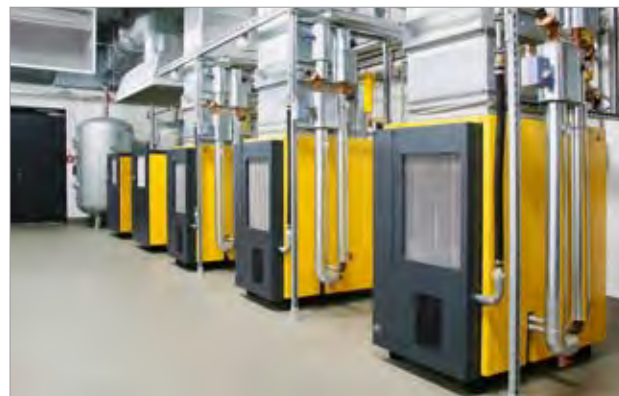
Instalación de canales de salida
